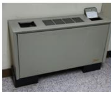
Un fan-coil (il cavo di alimentazione si attesta direttamente sui morsetti di ingresso dell'interruttore di protezione dell'apparecchio)
