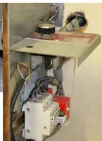
Un fan-coil (il cavo di alimentazione si attesta direttamente sui morsetti di ingresso dell'interruttore di protezione dell'apparecchio)
