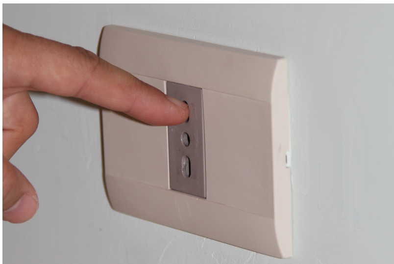
Figura n.5 Il grado di protezione IPXXB
