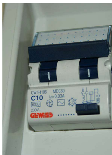
Figura n.6 Due interruttori differenziali (sono riconoscibili dallo schema elettrico, dal valore di corrente differenziale nominale I_{\Delta n} indicata sulla targa e dal tasto di prova)
