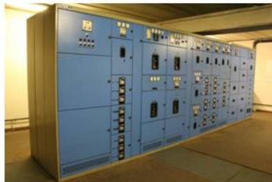
Quadro Generale di Bassa Tensione
