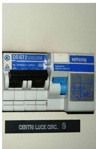
Figura n.6 Due interruttori differenziali (sono riconoscibili dallo schema elettrico, dal valore di corrente differenziale nominale I_{\Delta n} indicata sulla targa e dal tasto di prova)
